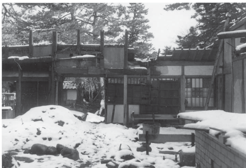
写真20 母屋倒壊状況 通用門側（昭和32年）
