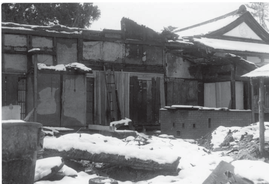
写真19 母屋倒壊状況 居宅側（昭和32年）
